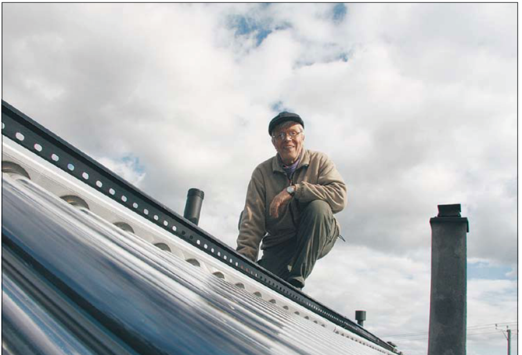
Pekka Vesterinen Vesi Oy:stä esittelee puoloista vuotta sitten rakennetun hirsitalon katolla olevaa kolmea keräintä, joissa kussakin on 15 tyhjiöputkea. Paraboliset peilit auttavat kohdistamaan kaikki säteet keräinten pinoille. Keräimet tuottavat lämpöenergiaa puolipilviselläkin säällä. KUVA: JAANA LARSSON
